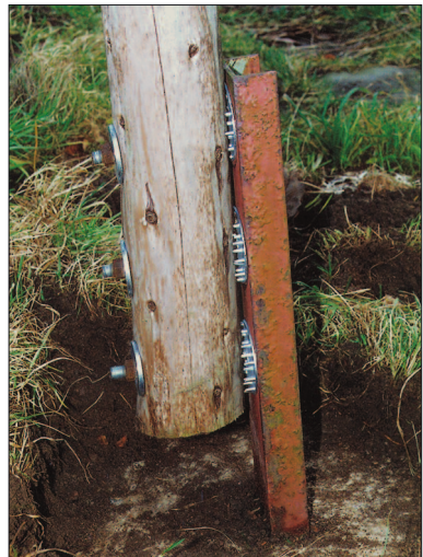
Einbetonierte Winkelisen
