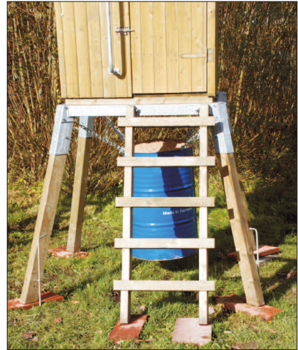
Angehänger Ballast bei konischem Unterbau (Das Fass sollte aus rein optischen Gründen mit dunkler Farbe gestrichen werden.)
