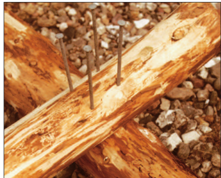
Knotenpunkt genagelt mit 4 Nägeln 4,2/120 je Anschluß
